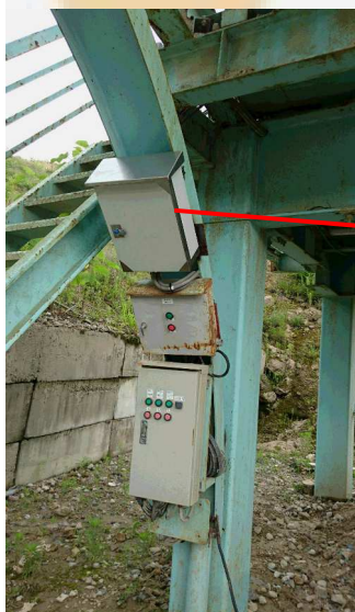
スターデルタ回路盤を付けた後
