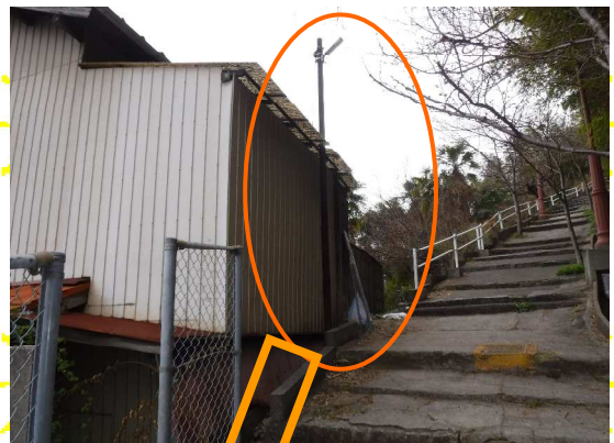
尾道市内古くなった防犯灯撤去
